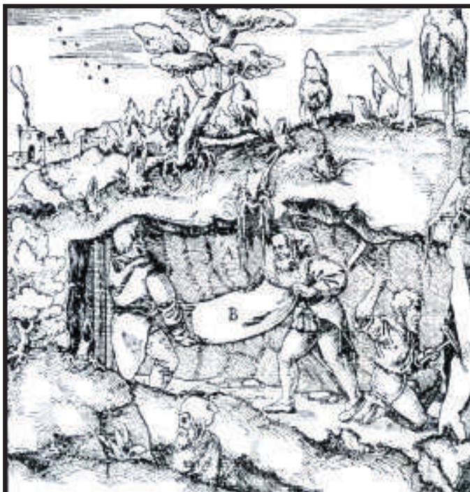
Работа со длето и чекан (Agricola), А - поткоп, В - помошно проветрување на работилиштето, С - рудар при работа
