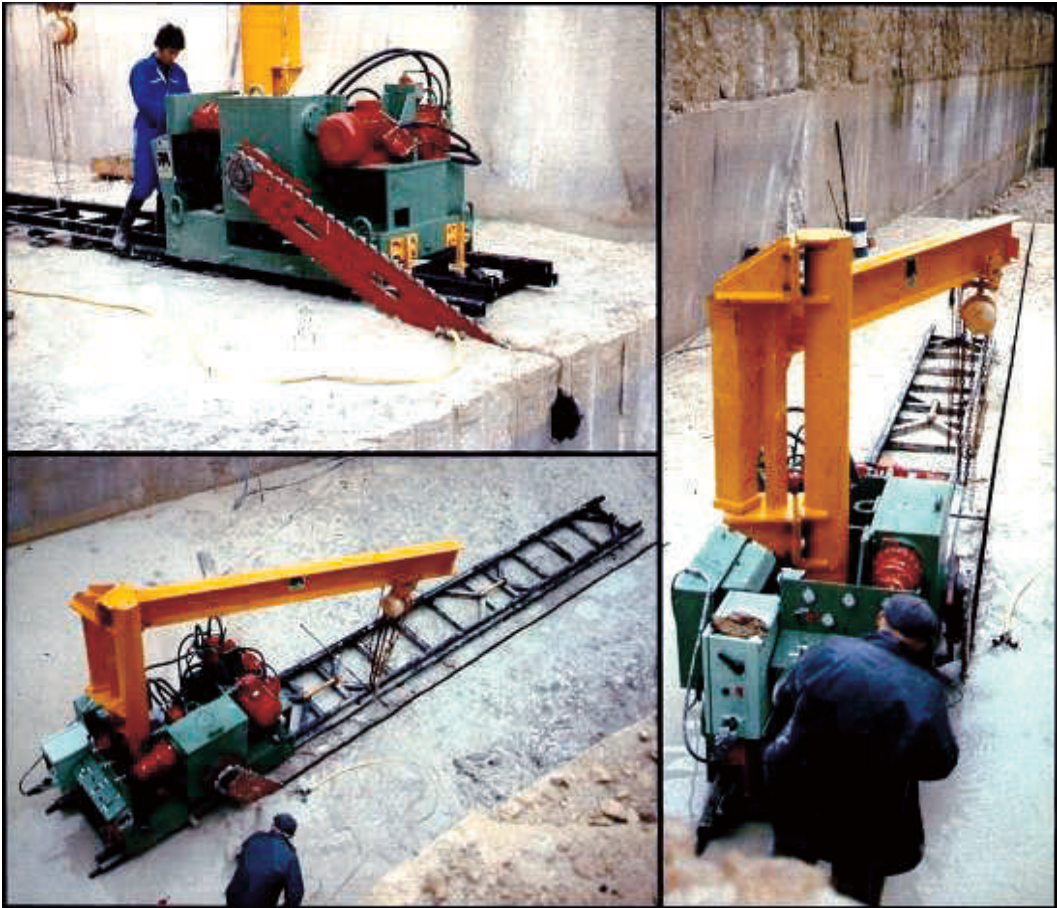
Сл. 174: Каменорезна машина Peggie при пилење хоризонтален рез во каменолом
